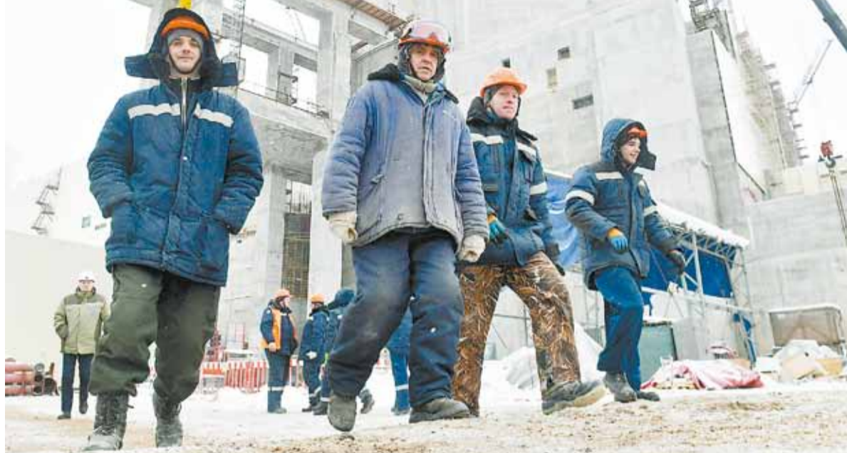
Уже установлены корпуса обоих реакторов ВВЭР - наиболее безопасных.
