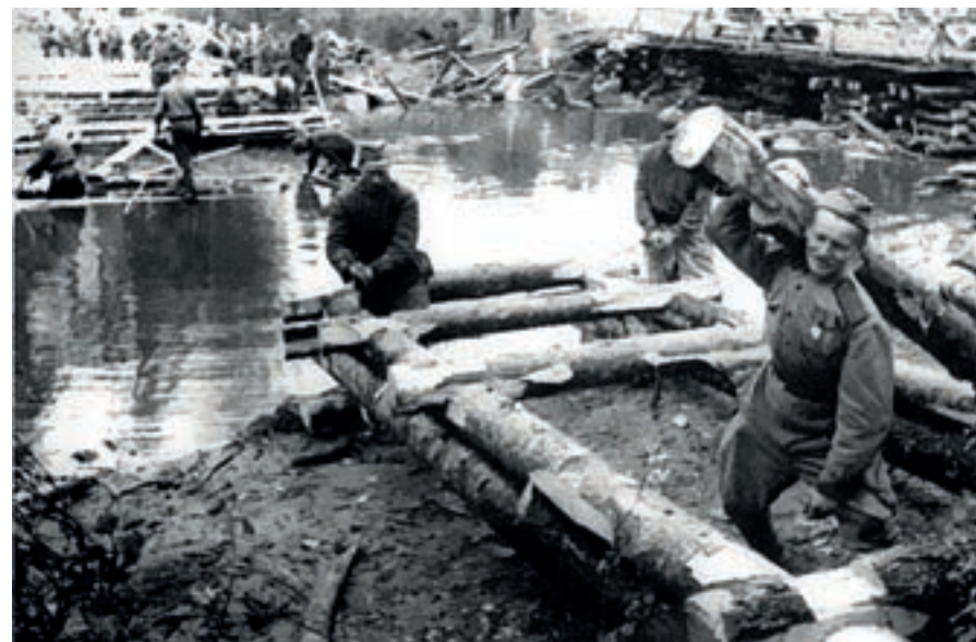
Строительство переправы через реку перед наступлением на Полоцк. 1-й Прибалтийский фронт, июнь 1944 года
