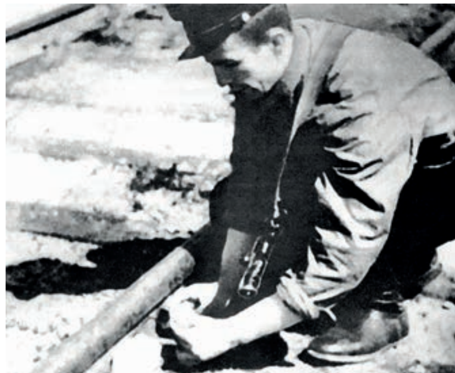
Подготовка к подрыву железнодорожного полотна
